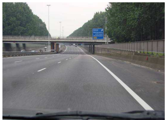
4a. Aquaduct van de Ringvaart in Nieuwerkerk a/d IJssel / Kijkrichting oost 200m voor de Ringvaart
