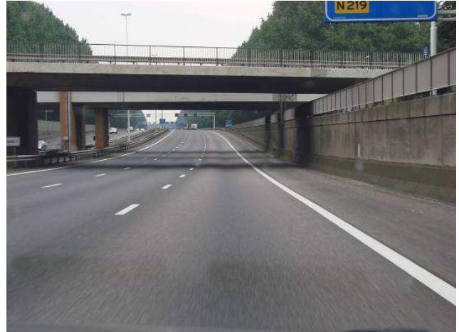
3a. Aquaduct van de Ringvaart in Nieuwerkerk a/d IJssel / Kijkrichting oost 100m voor de Ringvaart
