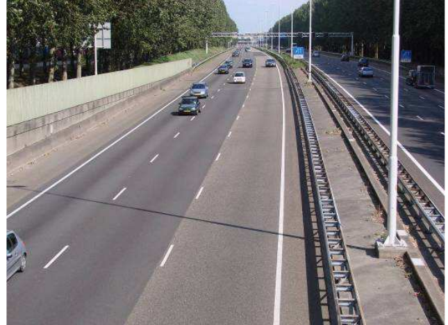
2a. Vanaf Aquaduct van de Ringvaart in Nieuwerkerk a/d IJssel / Kijkrichting oost over de A20
